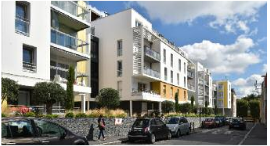
NOUVEAUX LOGEMENTS, RUE DES RÉFORMES © JEAN-DOMINIQUE BILLAUD
