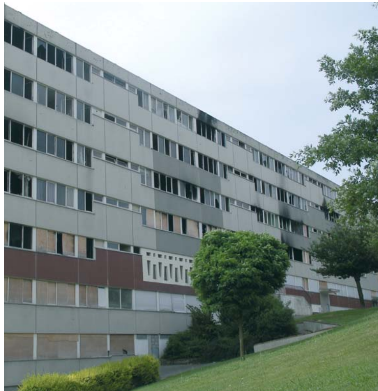
Coût de la démolition de l'immeuble Lepère : 6 000 € par logement soit 288 000 €. Maître d'œuvre : Coregi Entreprise en charge de la démolition : Occamat
