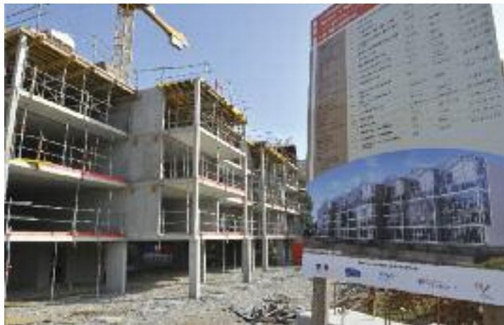
La livraison des logements est prévue pour juin 2011.
