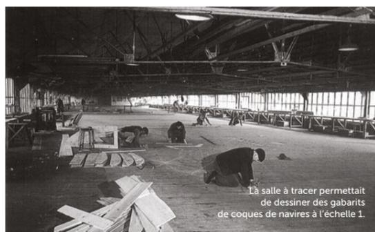
La salle à tracer permettait de dessiner des gabarits de coques de navires à l'échelle 1.
