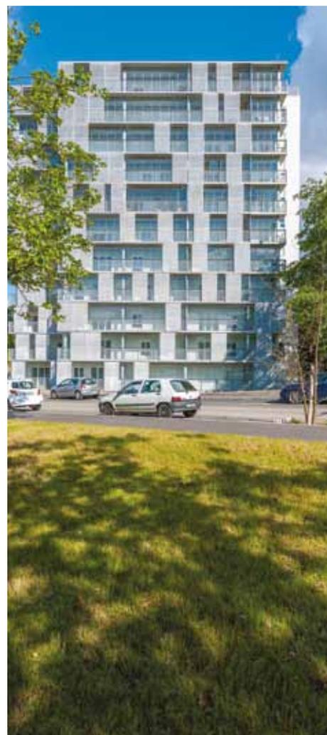
Démarrés en mars 2013, les travaux du 15 rue de Pont-Aven s'achèvent en juin. Rénovation des pièces humides, des sols, de l'électricité, des parties communes, mais aussi isolation thermique par l'extérieur et création de loggias en façade : le bâtiment offre désormais un meilleur niveau de confort aux locataires. « *Nous organisons une crémaillère en pied d'immeuble le 25 juin prochain* » explique Julie Faucillon, chargée du projet à
