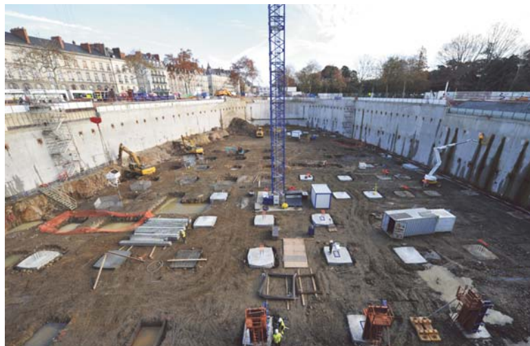
4800 kg d'explosifs utilisés pour fracturer la roche.
