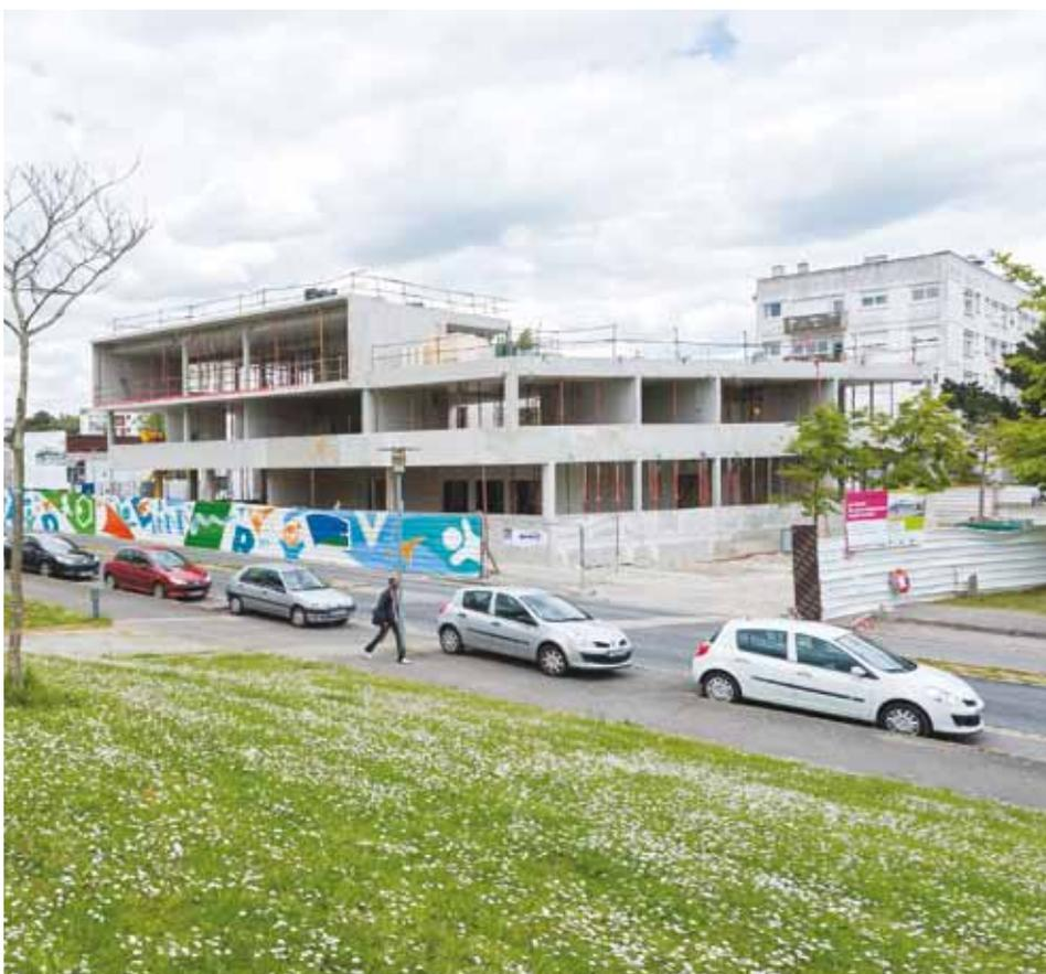
Démarré à l'automne dernier, le chantier du futur équipement emploi insertion se poursuit. Après le gros œuvre achevé au printemps, les travaux d'étanchéité (clos et couvert) sont en cours jusqu'en juillet. L'aménagement intérieur du bâtiment est prévu à l'automne jusqu'à la livraison en janvier 2014.
