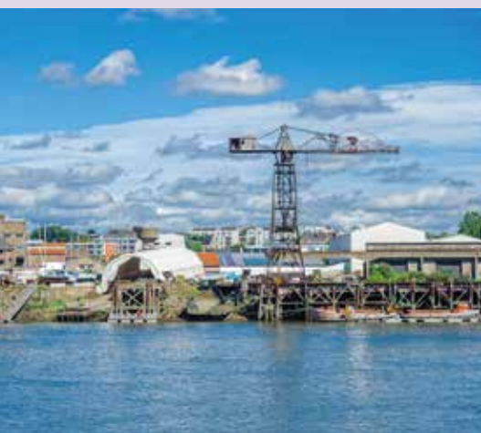
La grue noire des anciens chantiers navals Dubigeon
