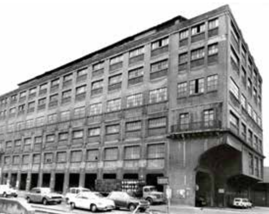
L'ancienne minoterie des Grands Moulins de Loire
