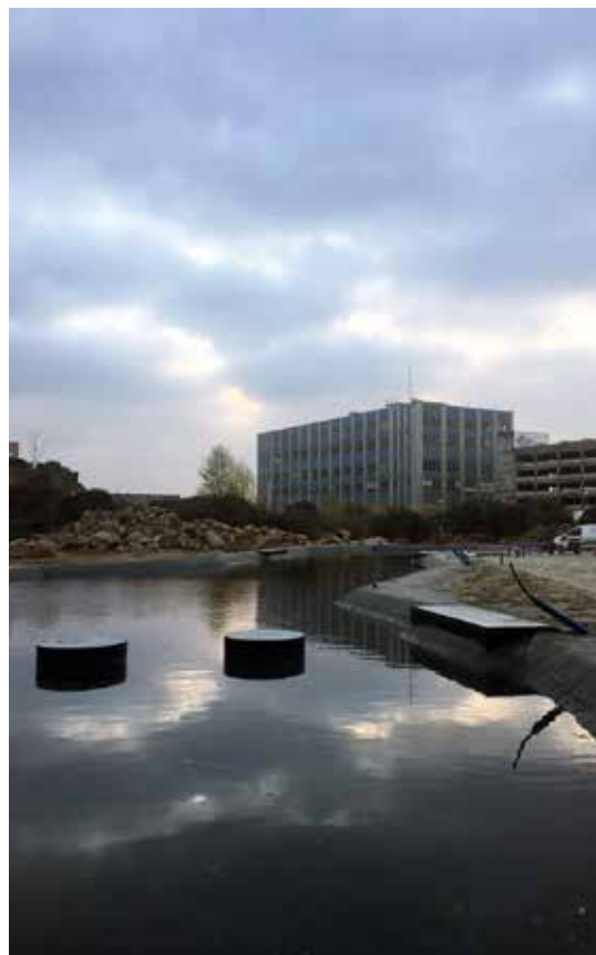
Essai de mise en eau du bassin pendant l'hiver.
