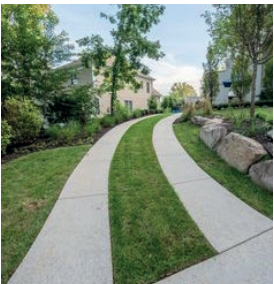
Bande de roulement béton
