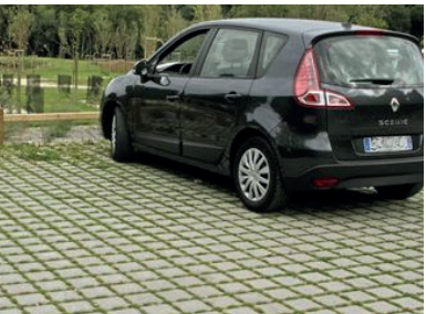
Pavés engazonnés ou à joints sable infiltrant
